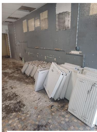
Dépose des radiateurs
